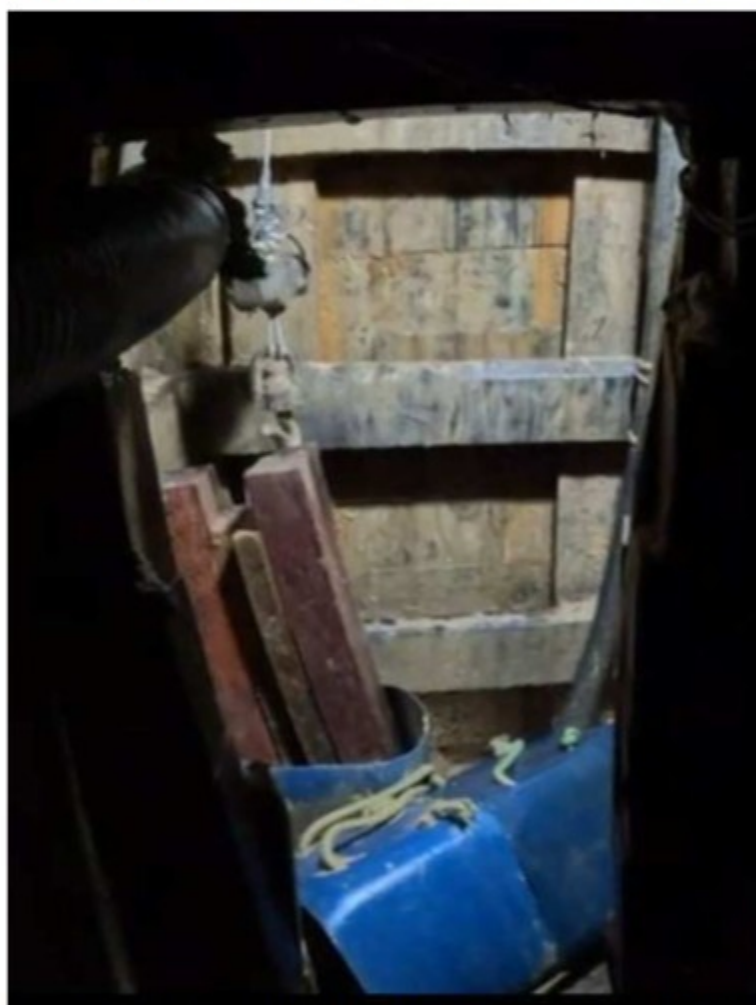
Fundo do poço com o guincho e tambores usados para a retirada de material.
