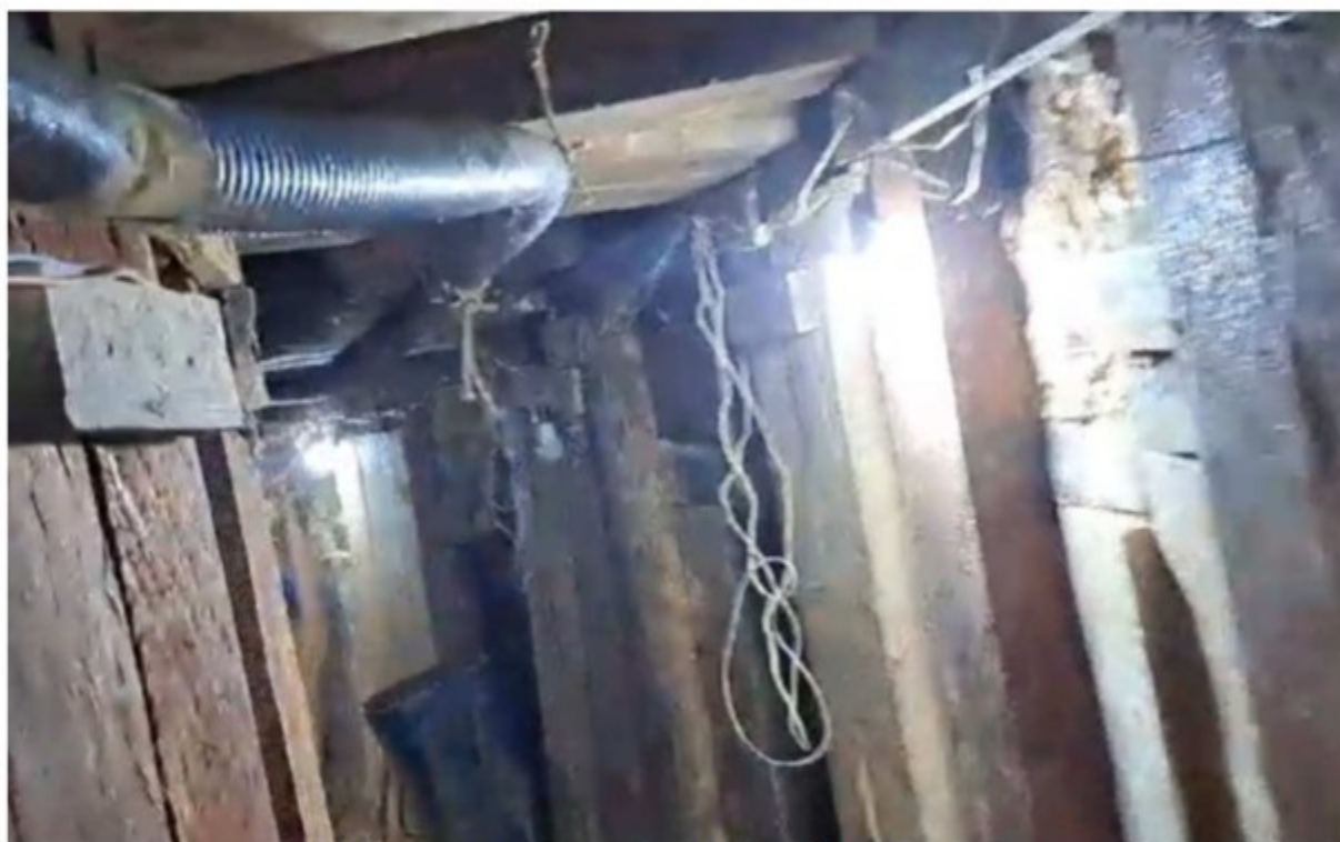
Imagem da galeria com fiação elétrica exposta.
