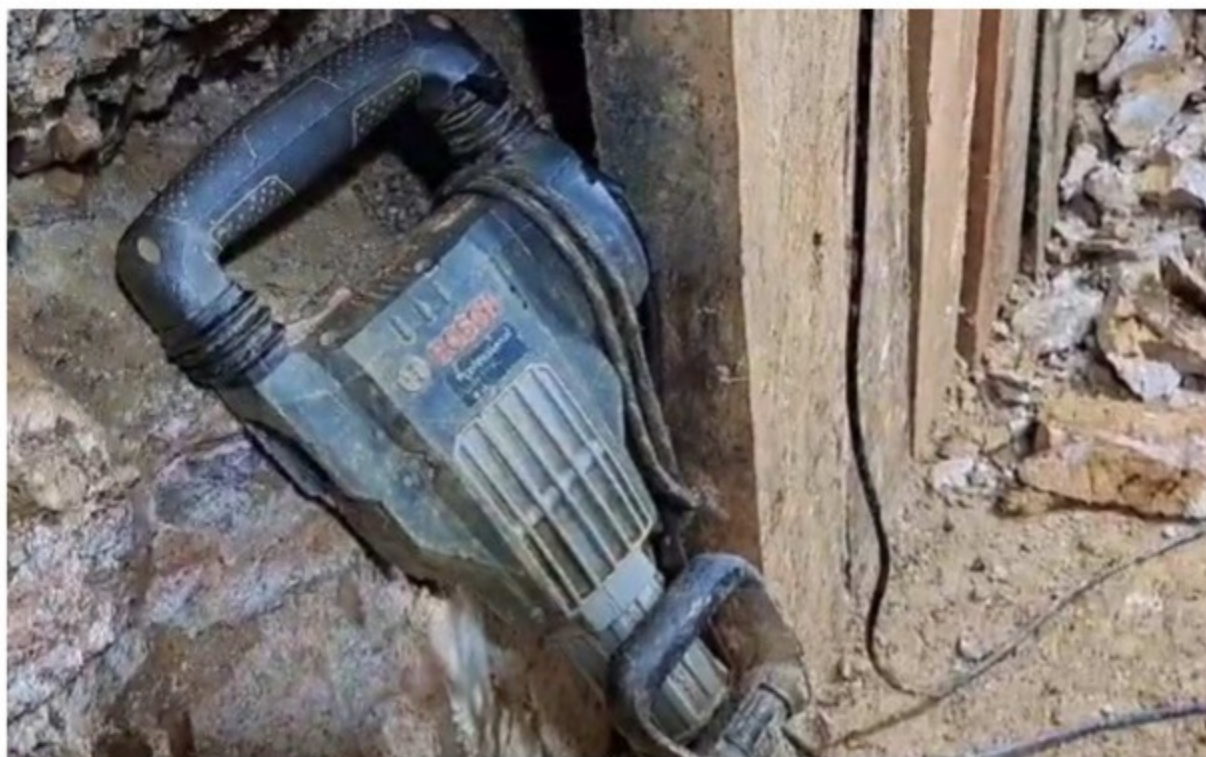
Martelete pneumático usado para desmonte de rocha.
