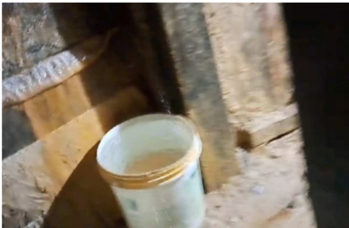
Balde no fundo do poço para recolher a água que se infiltra.
