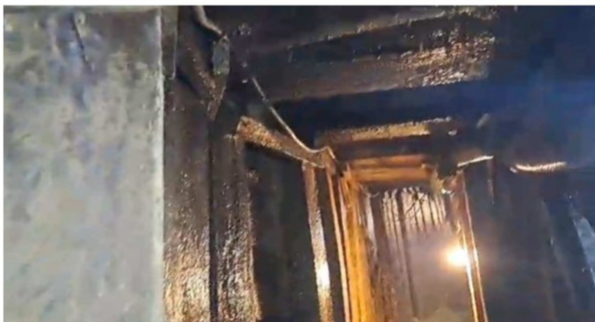
Paredes e teto encharcados de água da infiltração.
