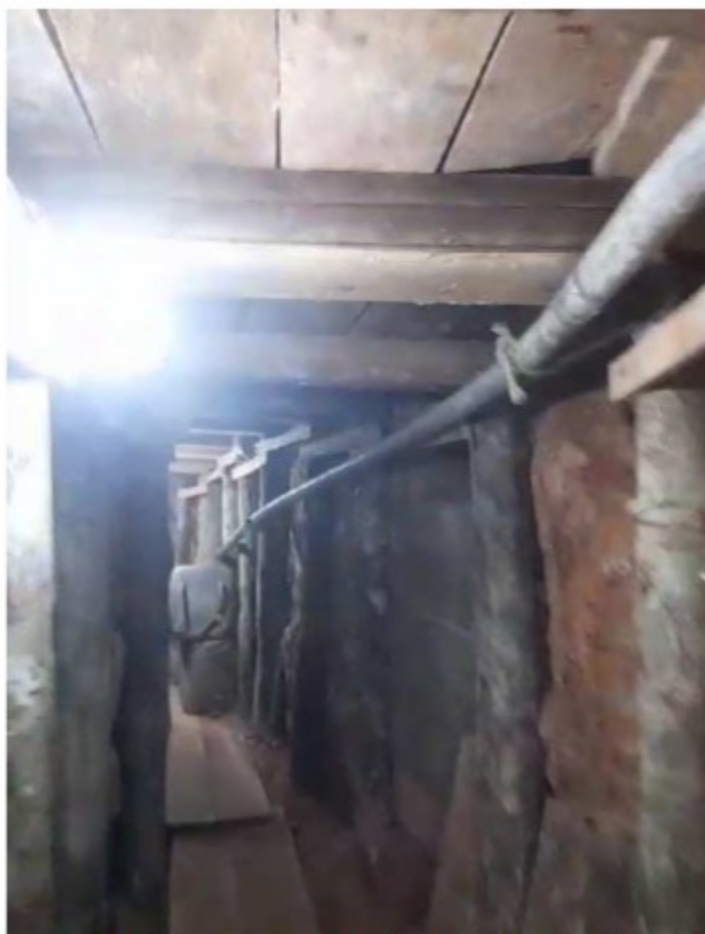
Imagem de uma das galerias. O cano escuro do lado direito é o duto que leva ar da superfície para o final da galeria.
