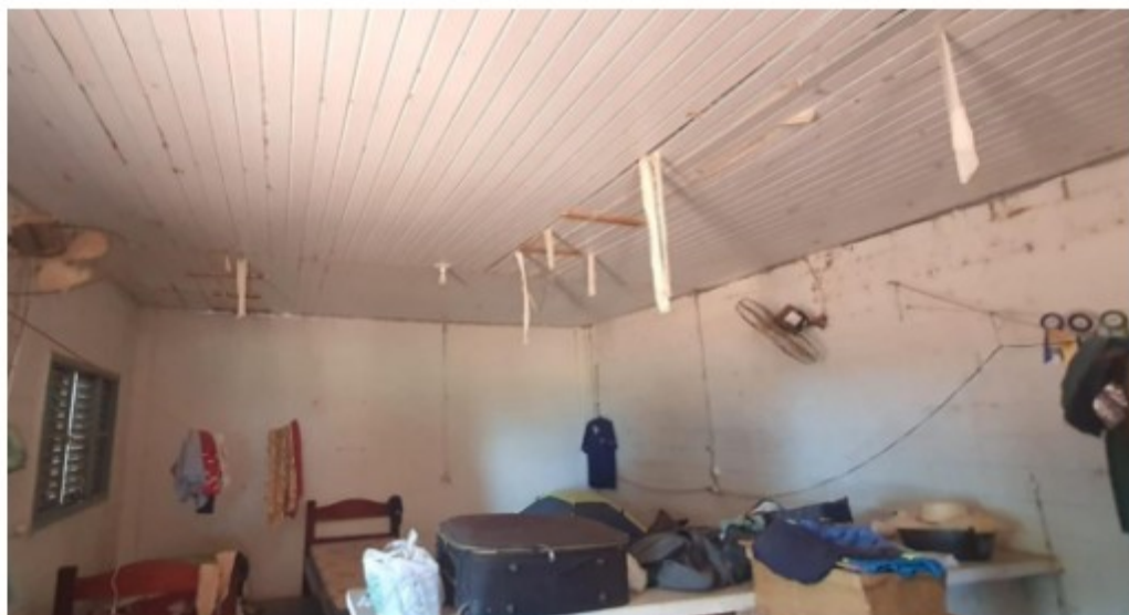
Foto 03: cobertura de policarbonato com algumas de suas placas soltas permitindo a entrada de poeira no dormitório.
