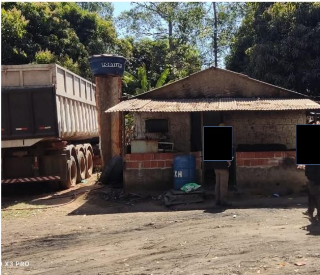
FOTO 15: Instalação utilizada como alojamento – vista externa.
