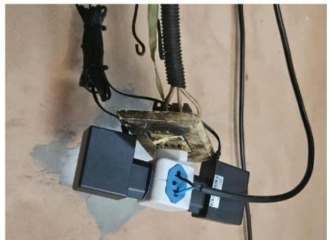
Que passando por cima do colchão alimentava os carregadores. Risco grave e iminente de choque elétrico.
