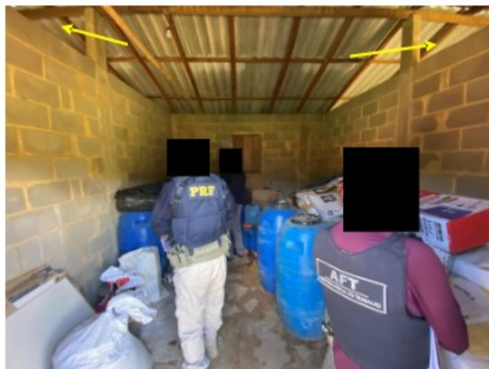
Foto 10: Imagem deixa ver que paredes internas da edificação não se estendiam até o teto, de modo a permitir que a peça utilizada para armazenamento de agrotóxicos se comunicasse com dormitórios.
