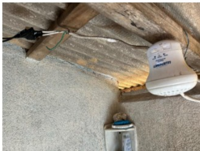
Foto 8: Registro fotográfico deixa patente a falta de aterramento elétrico do chuveiro na medida em que o fio terra se encontra rompido. Também é possível visualizar que a fiação elétrica não se achava isolada em calhas ou eletrodutos.
