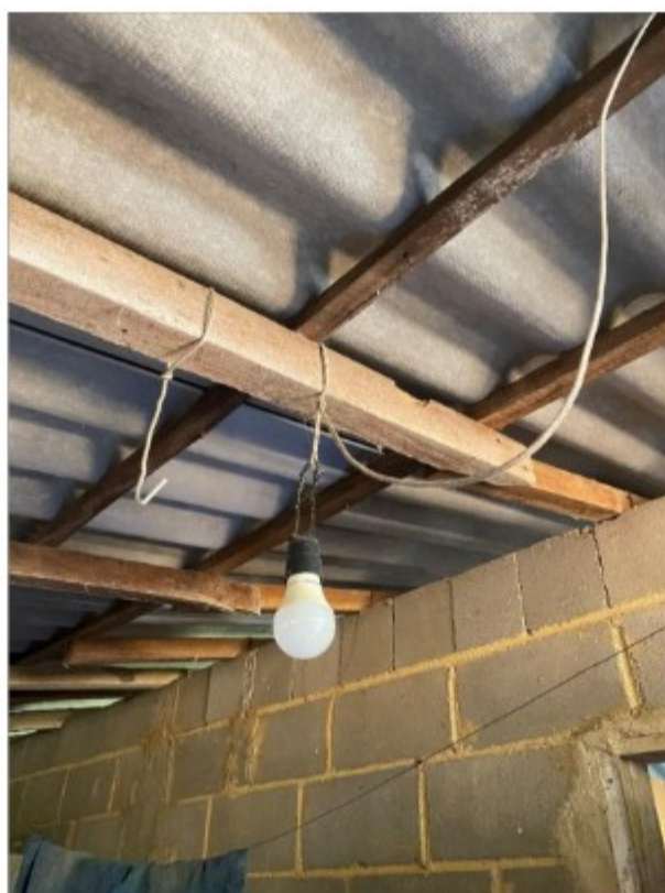
Foto 9: Outra imagem que evidencia a manutenção da fiação elétrica exposta, a oferecer risco de choque elétrico.
