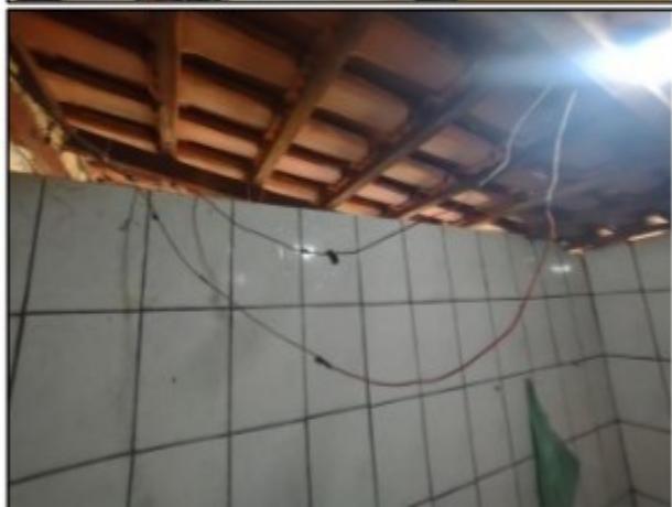
Fotos 43 a 48 – Fotos da instalação elétrica. Verifica-se a existência fios soltos.
