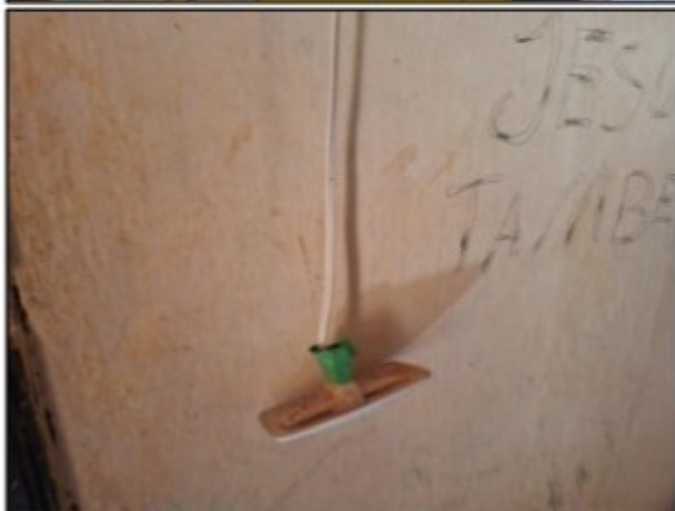
Fotos 43 a 48 – Fotos da instalação elétrica. Verifica-se a existência fios soltos.
