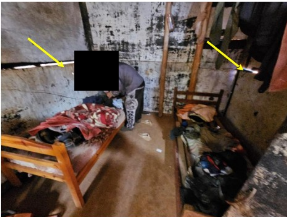
Imagem 19. Vista do interior do dormitório, mostrando algumas das frestas existentes nas paredes. Fotografia capturada em 09/09/2024.
