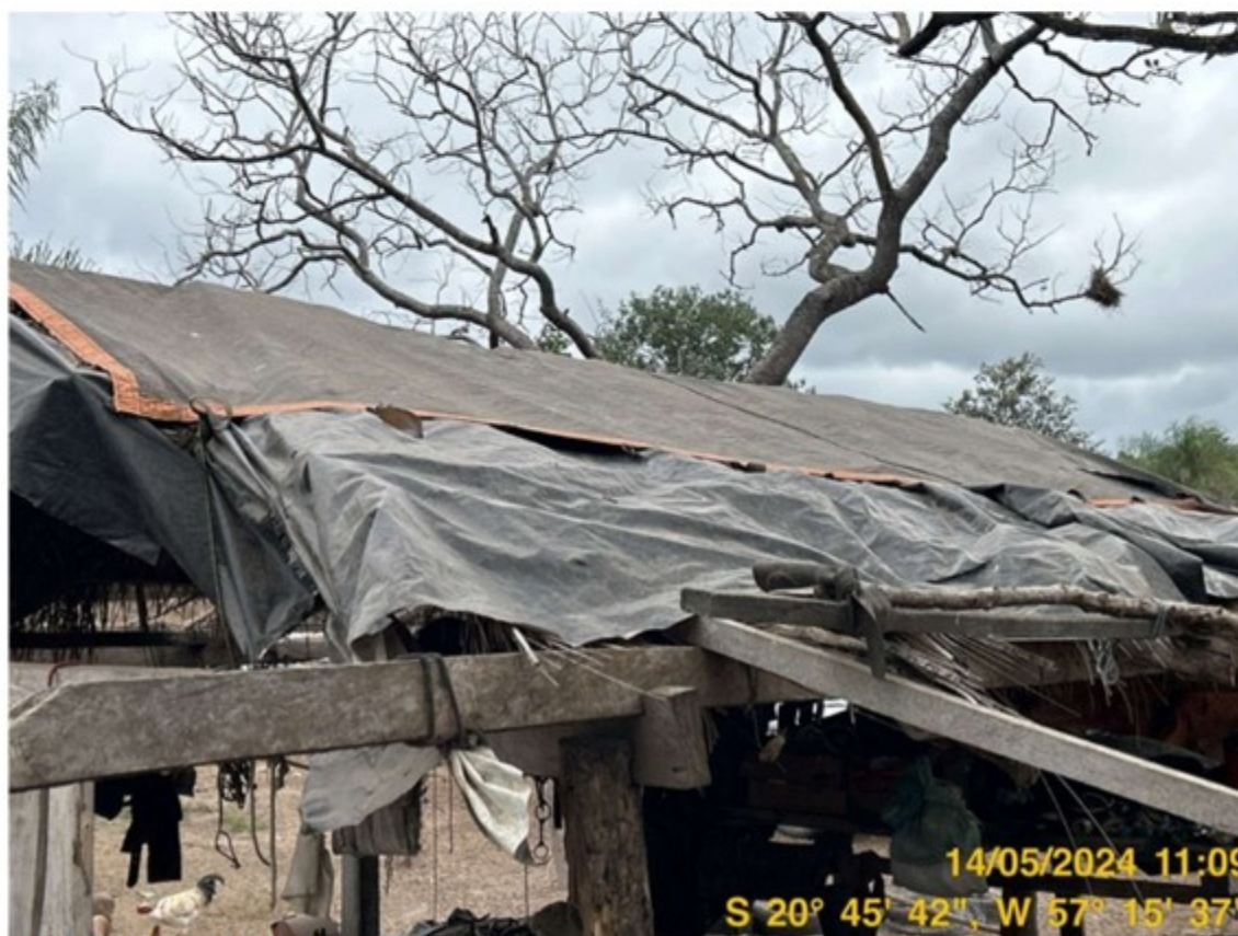
Foto 12: Cobertura da choupana
