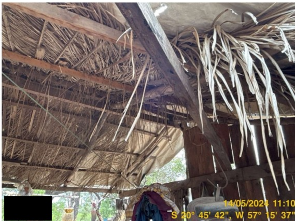
Foto 13: Cobertura da choupana
