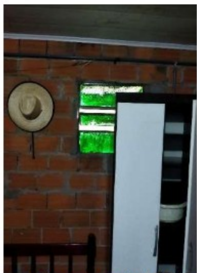
Ausência de ventilação do dormitório. Apenas uma janela basculante com apenas uma folha móvel.
