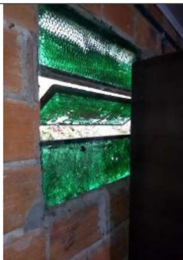
Ausência de ventilação do dormitório. Apenas uma janela basculante com apenas uma folha móvel.
