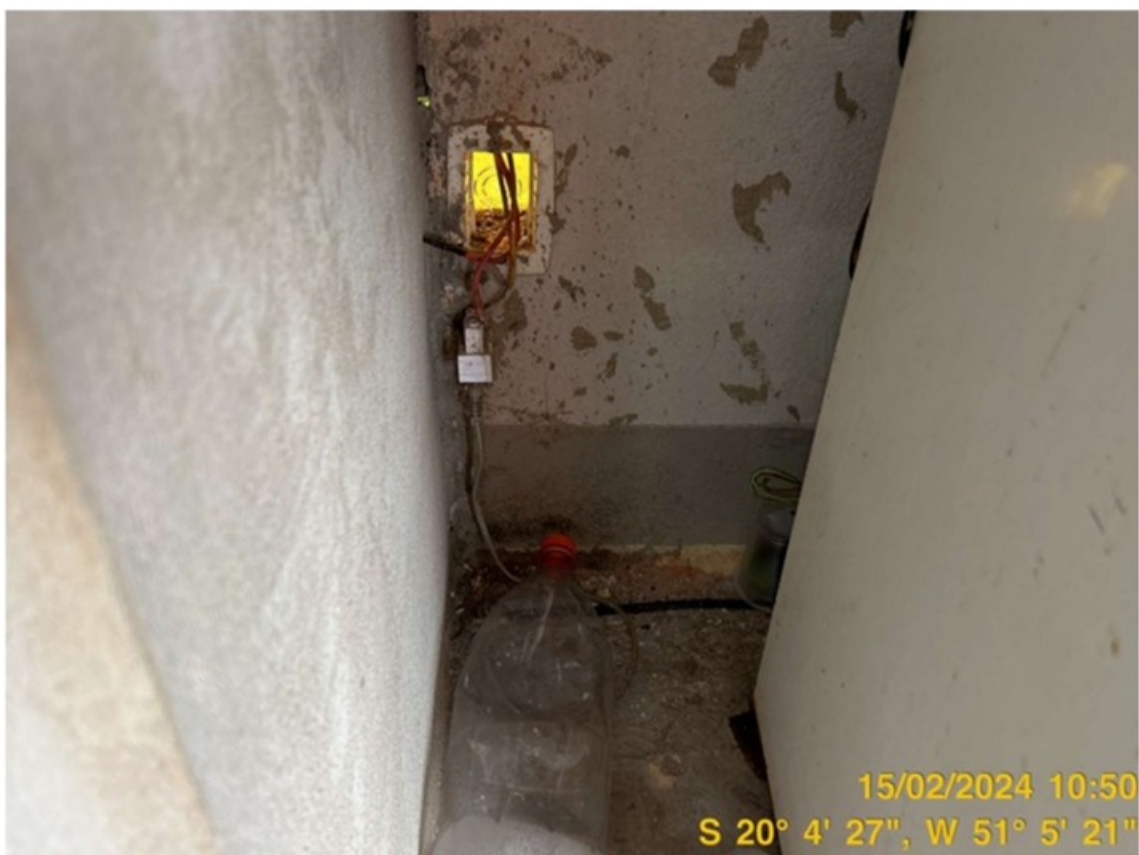
Foto 21: Instalações elétricas irregulares ( alojamento de trabalhadores )
