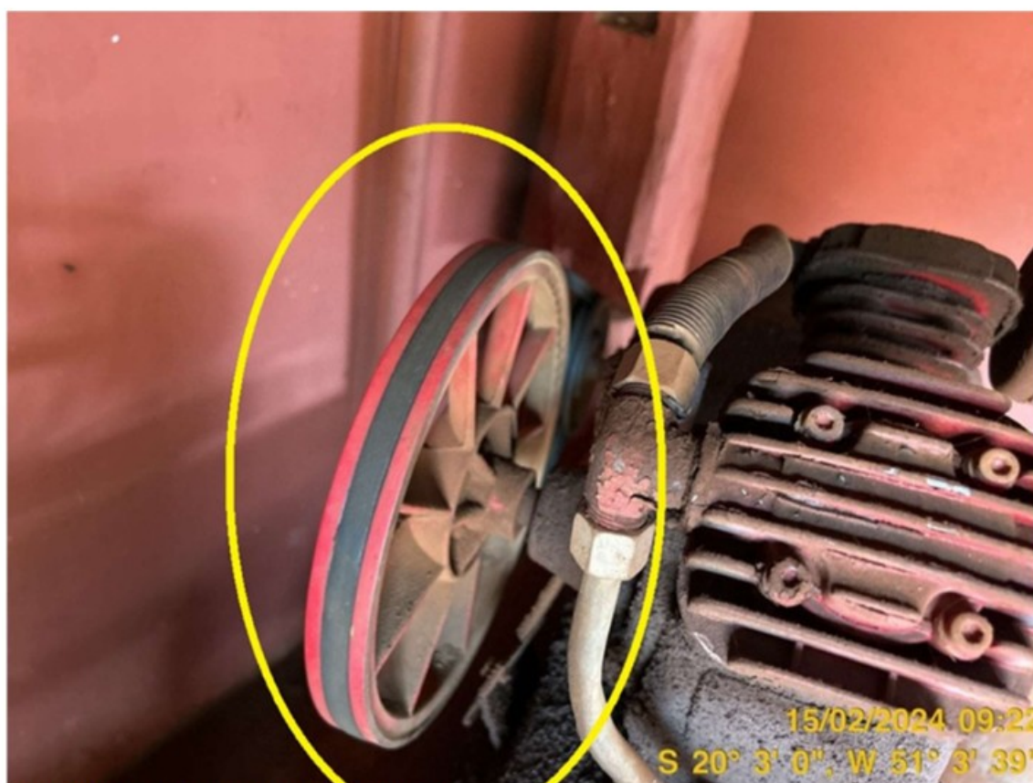
Foto 29: Transmissões de força sem proteção
