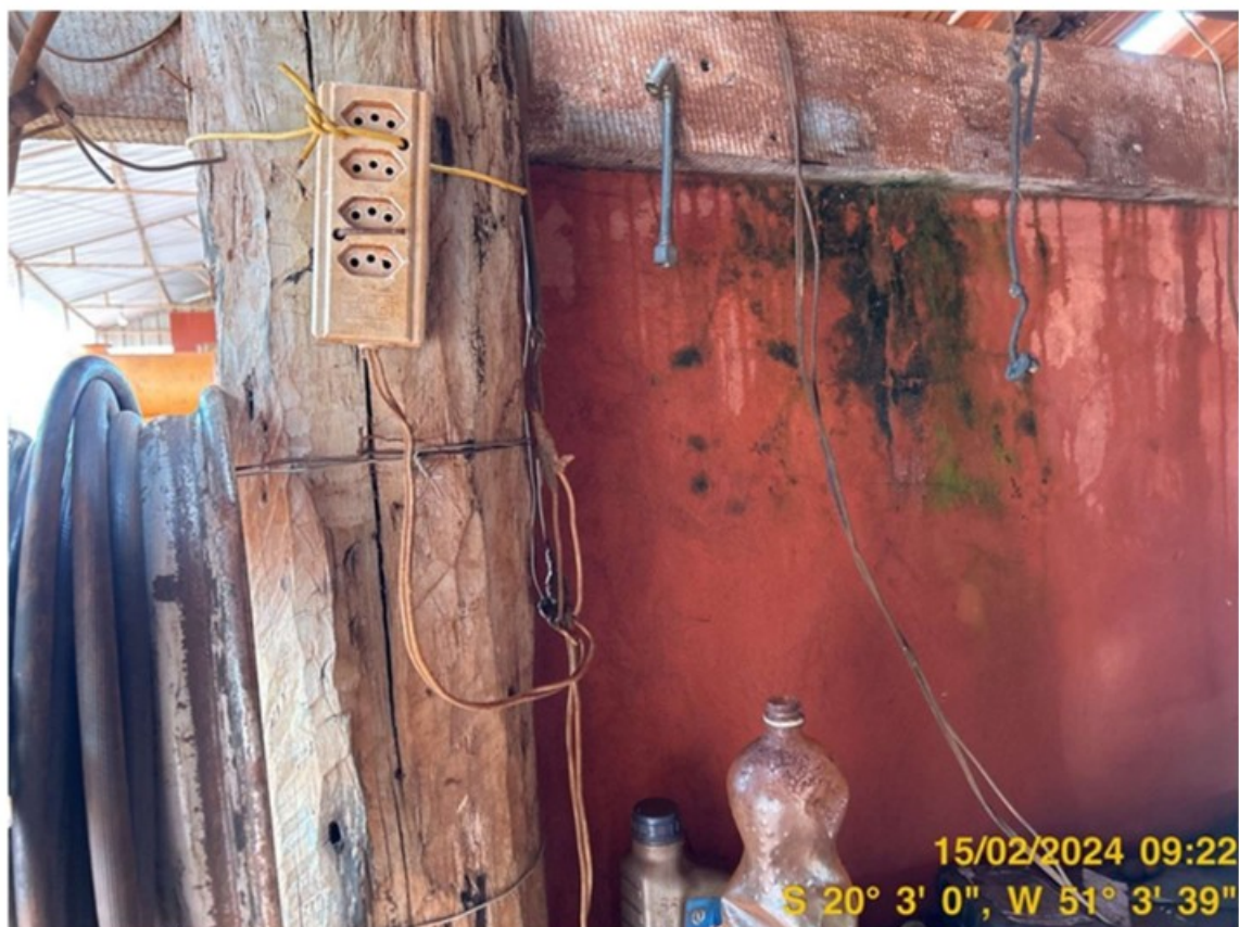
Foto 18: Instalações elétricas irregulares ( oficina mecânica da fazenda)
