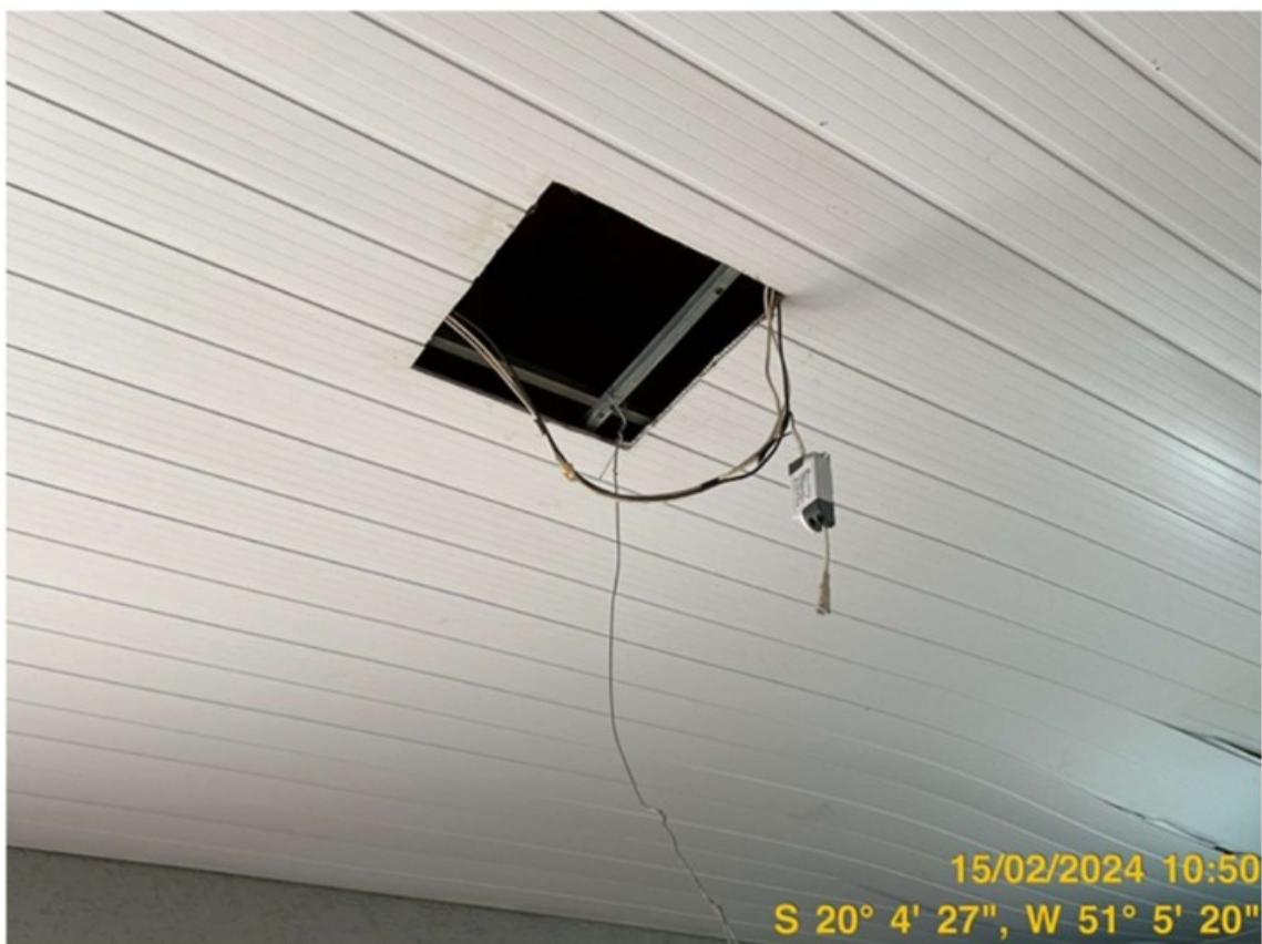
Foto 20: Instalações elétricas irregulares ( alojamento de trabalhadores )
