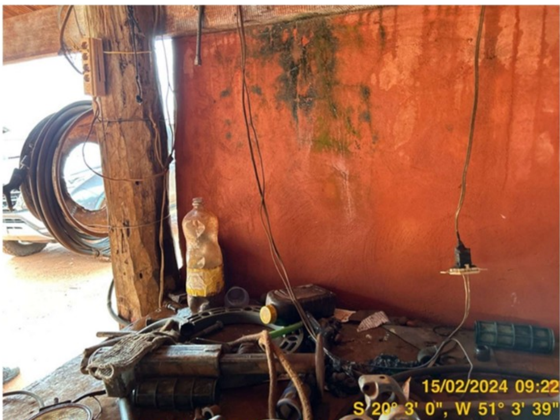
Foto 17: Instalações elétricas irregulares ( oficina mecânica da fazenda)
