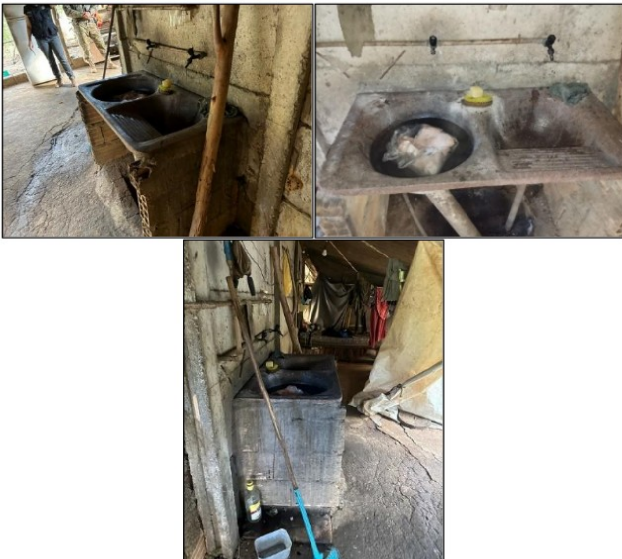
Fotos 73 a 75 - Tanque utilizado pelos trabalhadores para lavar suas roupas pessoais. O local era utilizado ainda para o asseio pessoal, na medida em que os trabalhadores relataram que realizavam a escovação dos dentes no mesmo lavatório em que lavavam alimentos, utensílios e roupas e, inclusive, punham de molho (como verificado no curso da inspeção) pedaços de carne, especificamente toucinho.
