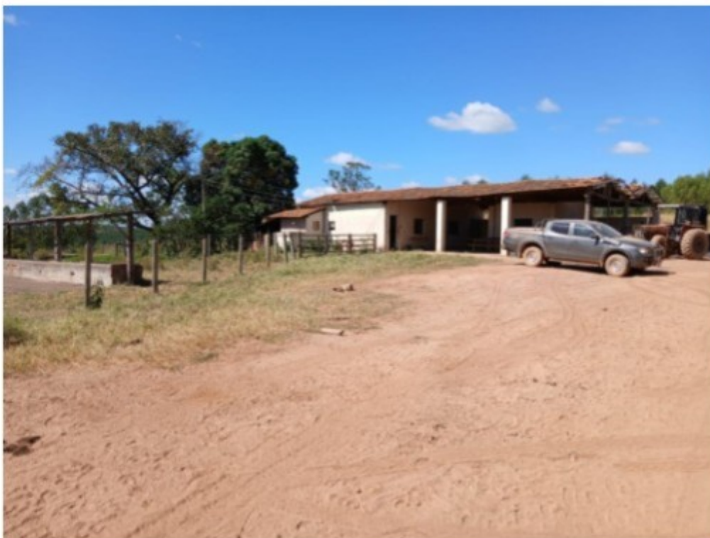
Foto 2: Imagem mostra o alojamento existente na sede da fazenda, de coordenadas geográficas S 19°6'54" W 45°12'5.20", em que se achavam alojados os obreiros [REDACTED] [REDACTED] e [REDACTED]
