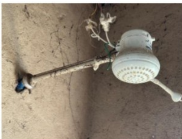
Fotos 19 e 20: Imagens mostram chuveiros elétricos dos alojamentos mantidos sem aterramento elétrico. Num deles, acima à esquerda, nem havia fio terra, enquanto no outro o fio terra estava rompido.
