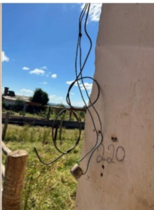
Fotos 21-24 : Registros fotográficos exibem a condição precária de manutenção e uso das instalações elétricas dos alojamentos, com fiação completamente exposta, isto é, não protegida por calhas ou eletrodutos.
