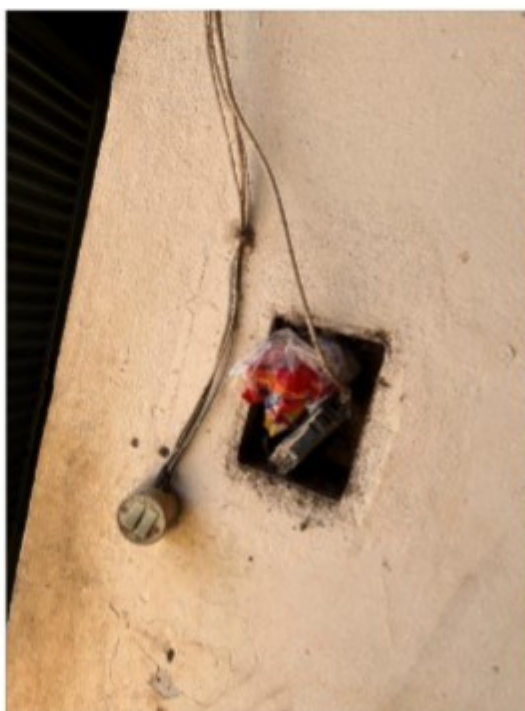
Fotos 21-24 : Registros fotográficos exibem a condição precária de manutenção e uso das instalações elétricas dos alojamentos, com fiação completamente exposta, isto é, não protegida por calhas ou eletrodutos.
