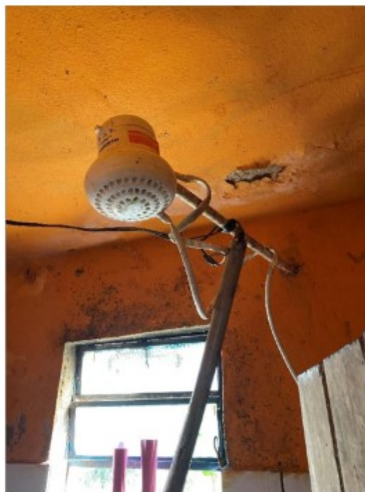
Foto 10: Registro fotográfico evidencia a manutenção de fiação exposta e a falta de aterramento elétrico do chuveiro do alojamento ocupado por [REDACTED] e [REDACTED]
