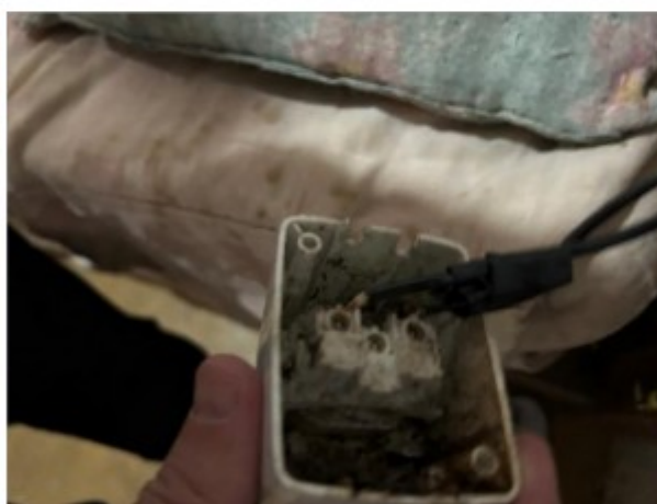
Fotos 12-15: Evidenciam a condição precária das instalações elétricas, com fiação completamente exposta, inclusive partes vivas.
