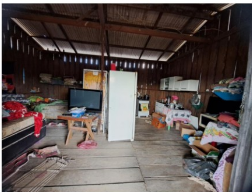
Interior da edificação utilizada como alojamento pelos trabalhadores
