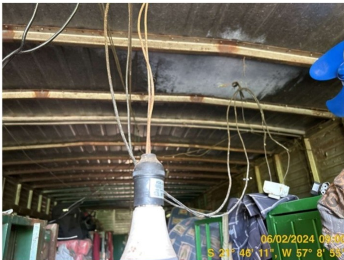
Foto 15: Carroceria caminhão-baú - alojamento de trabalhadores (detalhe das instalações elétricas irregulares)
