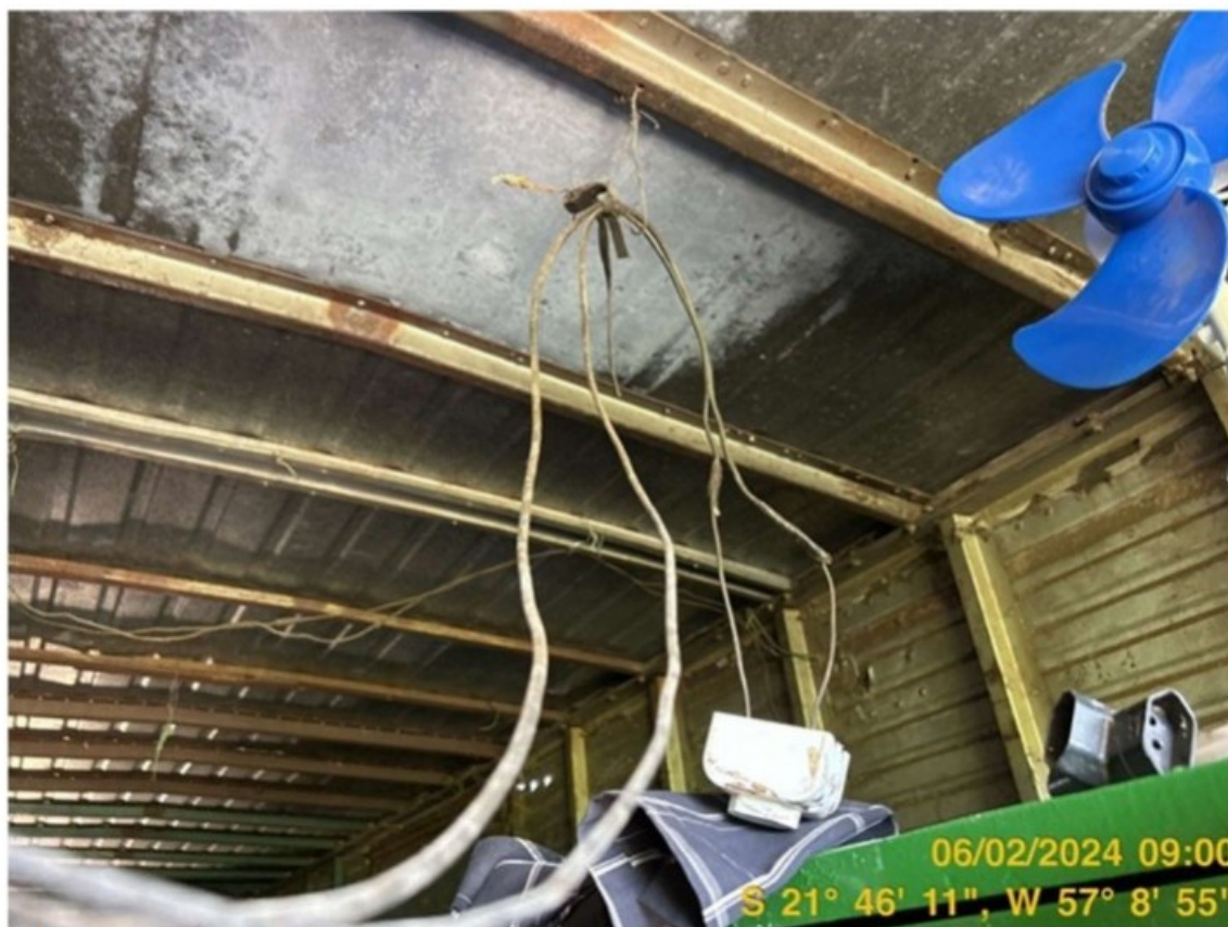
Foto 16: Carroceria caminhão-baú - alojamento de trabalhadores (detalhe das instalações elétricas irregulares)
