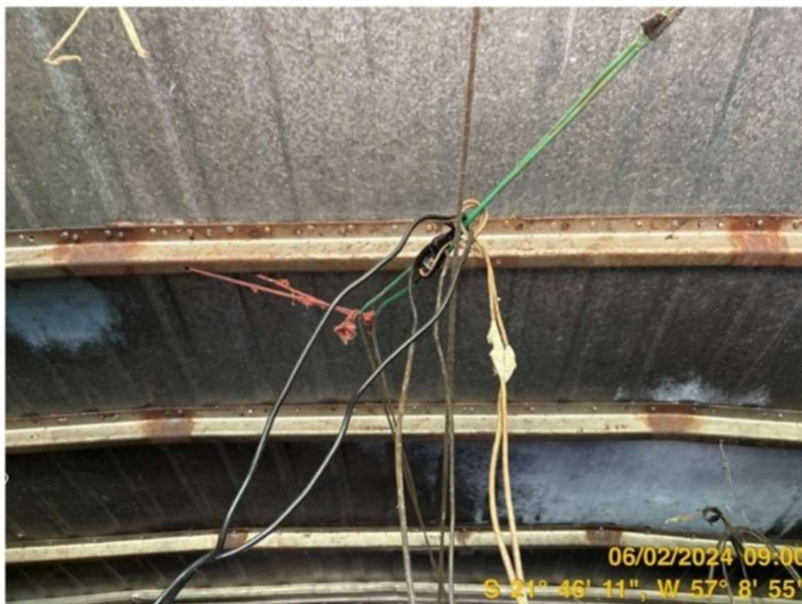
Foto 14: Carroceria caminhão-baú - alojamento de trabalhadores (detalhe das instalações elétricas irregulares)
