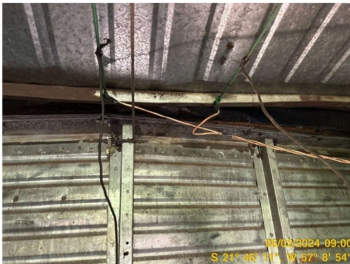
Foto 17: Carroceria caminhão-baú - alojamento de trabalhadores (detalhe das instalações elétricas irregulares)
