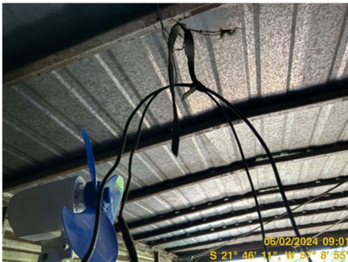
Foto 18: Carroceria caminhão-baú - alojamento de trabalhadores (detalhe das instalações elétricas irregulares)
