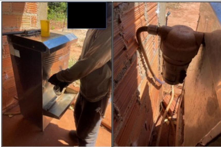
Bebedouro metálico instalado na parte frontal da casa de alvenaria.
