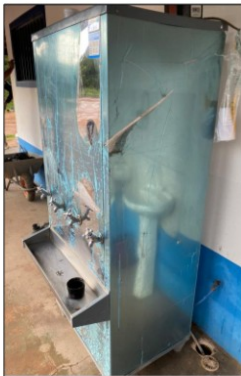
Foto 8 - Bebedouro industrial com filtro acoplado.
