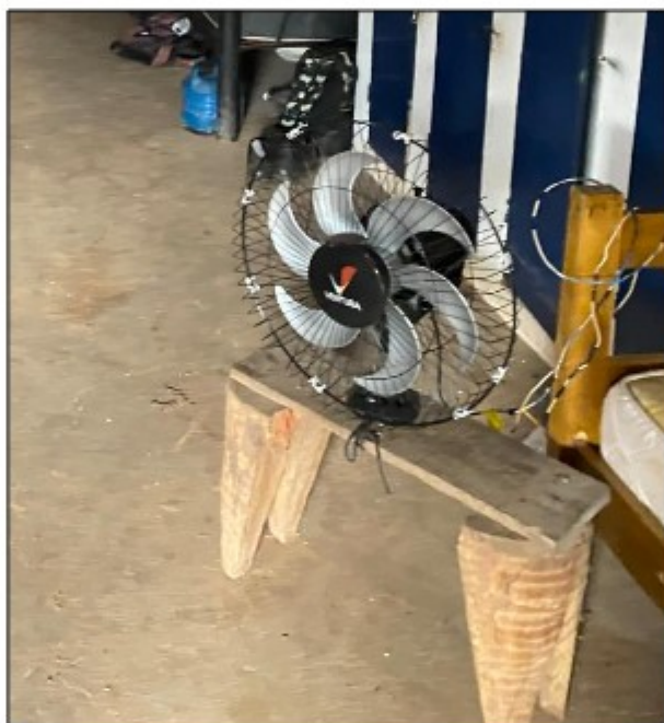
Fotos 10, 11 e 12 - Ausência de fornecimento de roupas de cama e gambiarras elétricas para ligação de ventiladores e das tomadas de celular.
