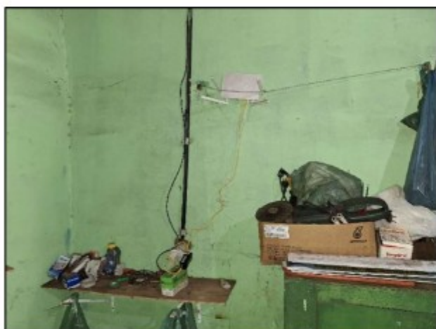
Fotos 21 a 24: fiação elétrica exposta e derivações inadequadas.
