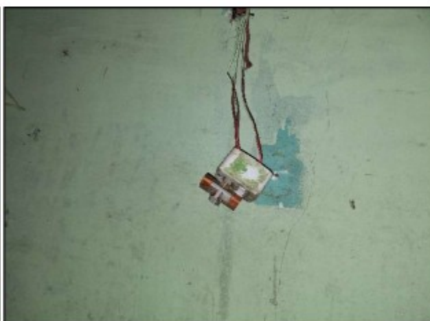
Fotos 21 a 24: fiação elétrica exposta e derivações inadequadas.
