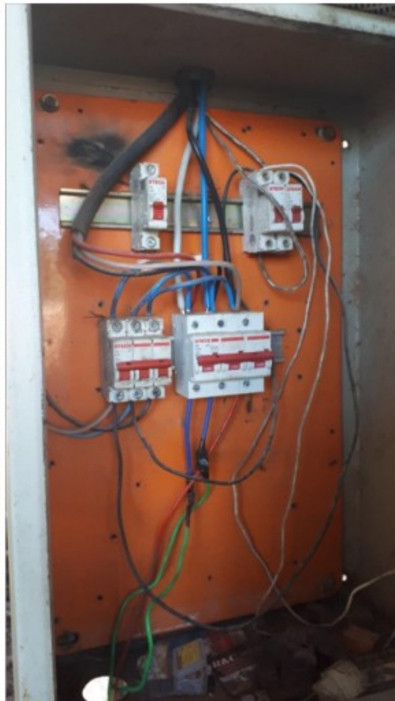
Imagens acima: exemplo de instalações elétricas precárias.
