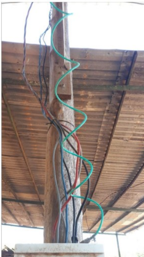
Imagens acima: exemplo de instalações elétricas precárias.
