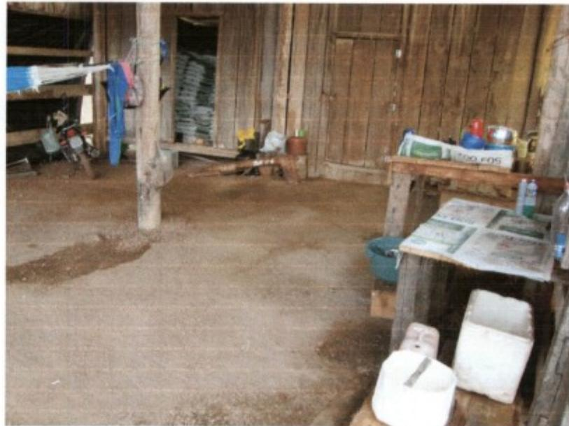
Os demais trabalhadores ocupavam o vão livre da instalação que era coberta por telhas de amianto e sustentada por vigas e pilares de madeira roliça, mas não tinha as laterais protegidas por paredes. Improvisou-se em partes da lateral do galpão pedaços de lona nas cores amarela e preta, talvez para garantir um mínimo de privacidade e de proteção contra as intempéries, mas que obviamente, não cumpriam o objetivo para o qual foram usadas.
