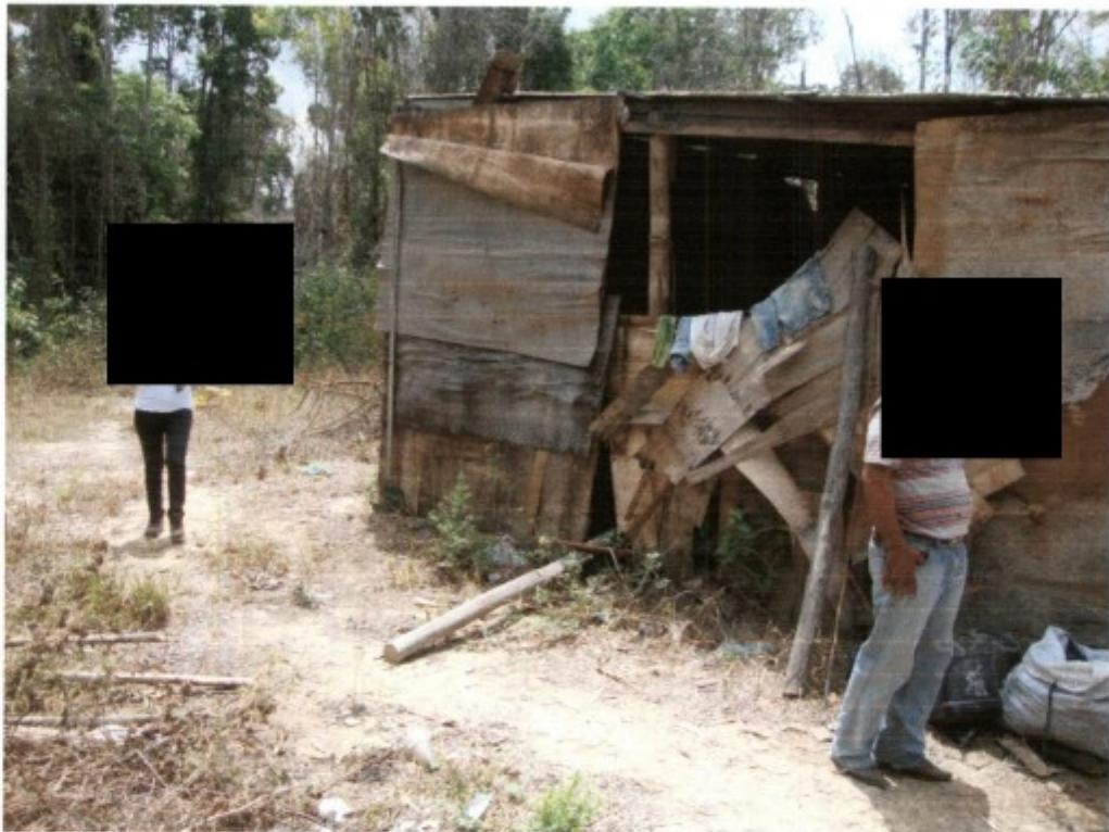
Ocorre que em razão da ação das chuvas, do sol e do tempo, estas folhas de compensado já se encontravam em adiantado estado de deterioração. Não havia portas, nem janelas.
