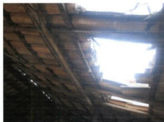
Completamente destruído pela ação do tempo e pela falta de asseio e conservação, o local usado como abrigo estava a ponto de desabar. As vigas e pilares de madeira roliça que sustentam paredes e telhado apresentavam evidentes sinais de apodrecimento, havendo inclusive, dessas peças, umas que já estavam envergadas a ponto de partirem-se.
