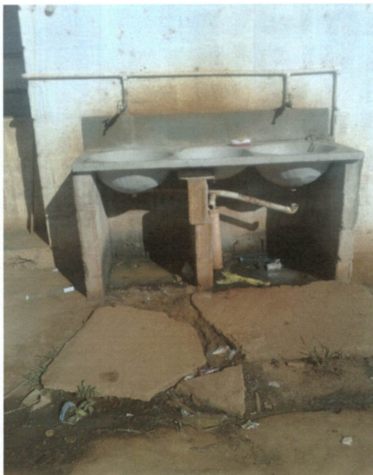
Foto 7 – Tanque para lavagem dos utensílios de cozinha. O esgoto de conexão à fossa estava entupido. Os tubos de escoamento foram desconectados para dar vazão às águas servidas, que corriam a céu aberto, quando havia água.
