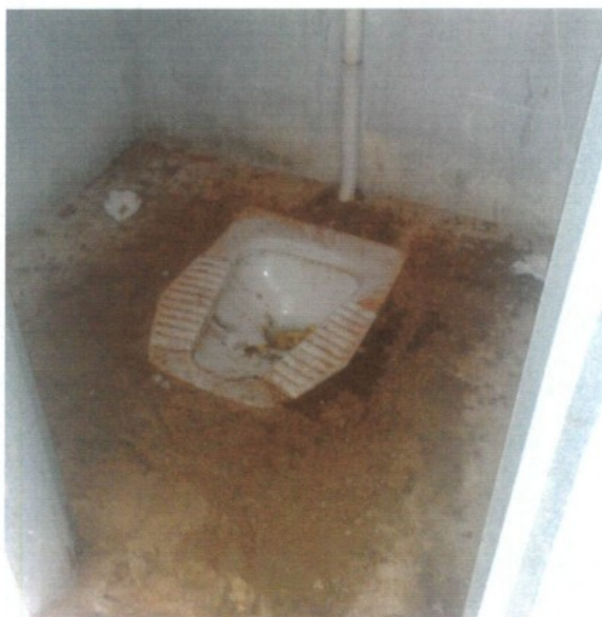
Foto 6 – Instalação sanitária em precárias condições de higiene. A limpeza era prejudicada pela crônica falta de água. Várias instalações se encontravam inoperantes
