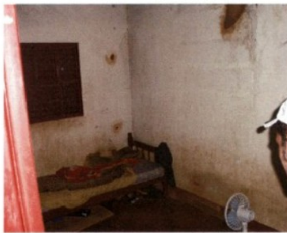
Fotografia de alojamentos com ausência de vedação e forro nos tetos e paredes prejudicadas pela infiltração de água das chuvas.
