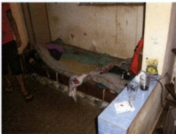
Fotografia de alojamentos com ausência de vedação e forro nos tetos e paredes prejudicadas pela infiltração de água das chuvas.
