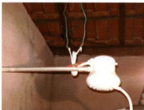
Fiação exposta no banheiro de um dos alojamentos inspecionados
