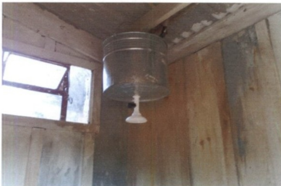
Chuveiro tipo "campanha", instalado no dia anterior (água fria).
