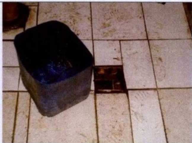
Piso do chuveiro, por onde escoa a água sem qualquer proteção e vasilha utilizada pelos trabalhadores para jogar água no vaso após o uso.
