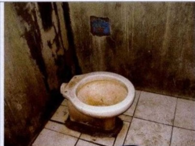
Instalação sanitária não tinha sequer as tubulações e pia sem condições de uso
