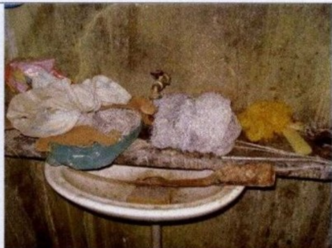
Instalação sanitária não tinha sequer as tubulações e pia sem condições de uso
