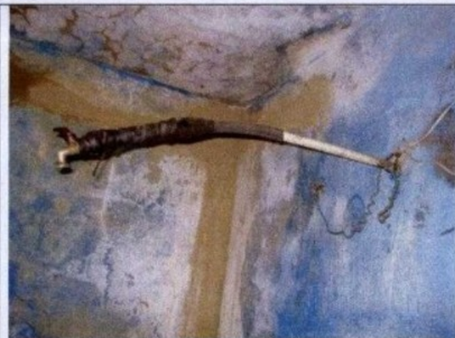
Cabo disponibilizado para servir de chuveiro para os trabalhadores, fiação desconectada e sem isolamento.
