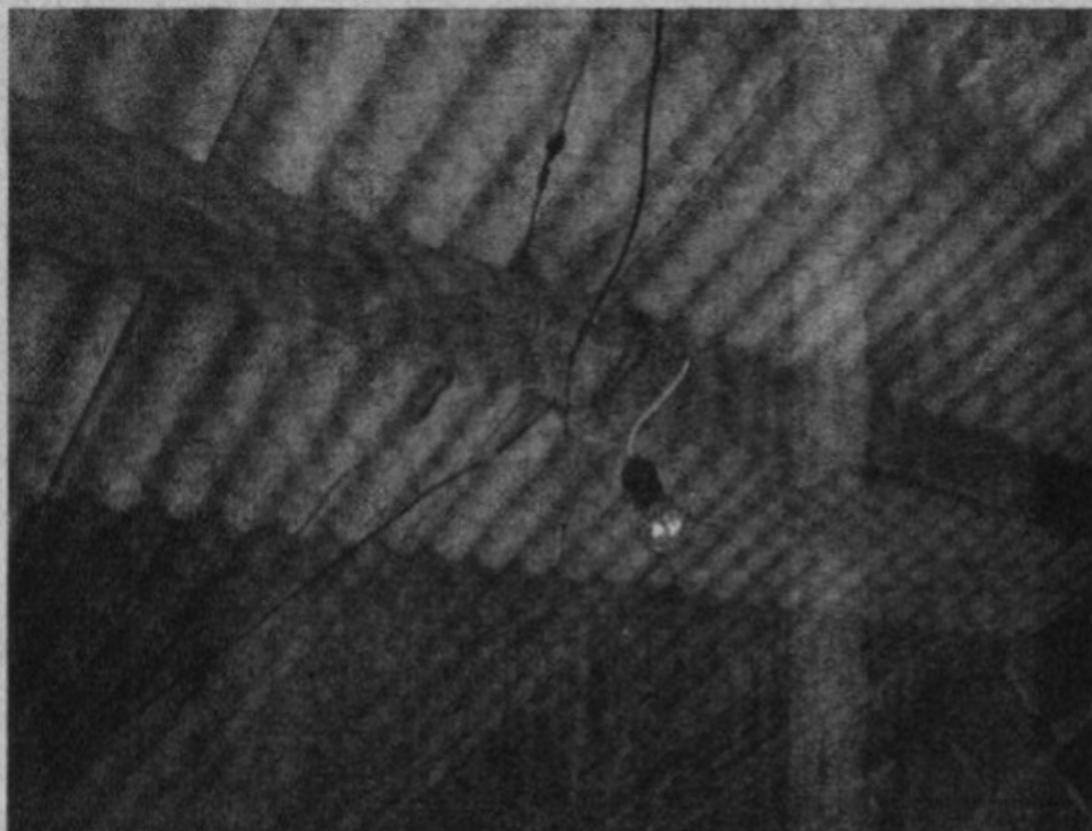
Instalações elétricas expostas com emendas não isoladas.
