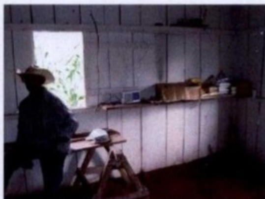
Note-se a grande quantidade de terra acumulada no chão ao longo das paredes (esq.) e a falta de compactação do piso.
