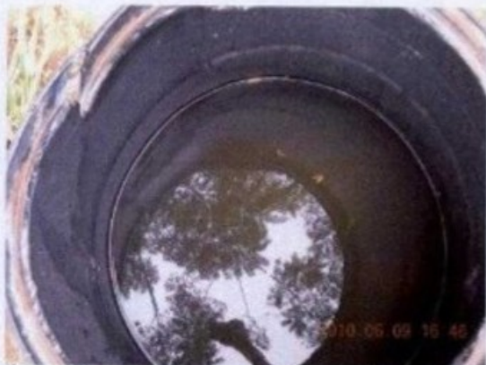
Água no recipiente de armazenamento (esq.) e no poço, sem características físicas de potabilidade.
