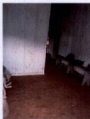
Note-se a grande quantidade de terra acumulada no chão ao longo das paredes (esq.) e a falta de compactação do piso.
