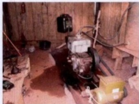
Motor que bombeava a água do poço até a caixa d'água. Recipiente reaproveitado para armazenar água.
