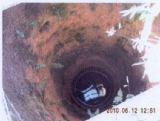
Poço sem revestimento e descoberto, de onde os trabalhadores coletavam água.
