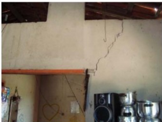
Rachaduras e cupins nas paredes e nas vigas (dir.).
