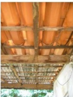
Rachaduras e cupins nas paredes e nas vigas (dir.).
