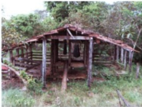
Antigo chiqueiro onde permaneciam trabalhadores.
