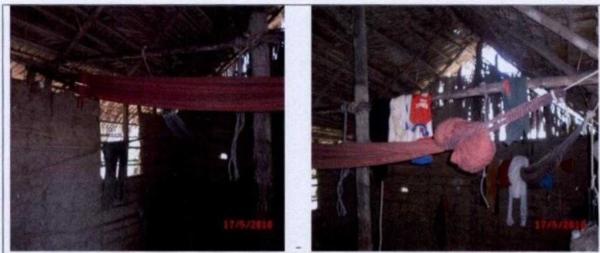
paredes do barraco sem a devida vedação contra intempéries
