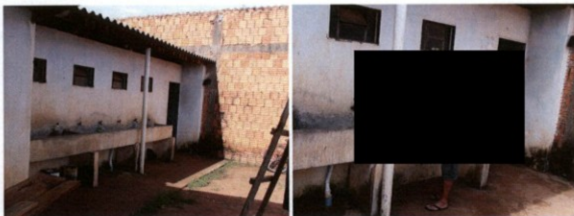
Torneiras de plástico instaladas numa calha de cimento, funcionam como bebedouro
