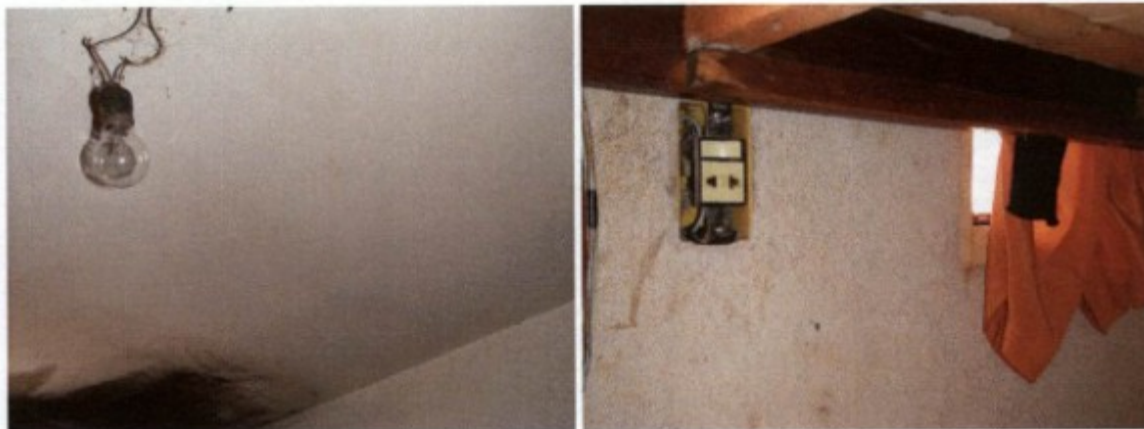
Instalações elétricas com risco de choque elétrico
