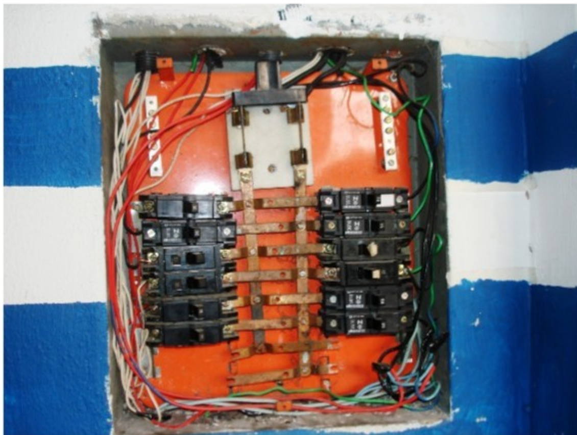
Complexo Oficinista da Casa Verde Alta – 11/08/2010 – quadro elétrico com partes vivas expostas e sem aterramento – risco de incêndio.
