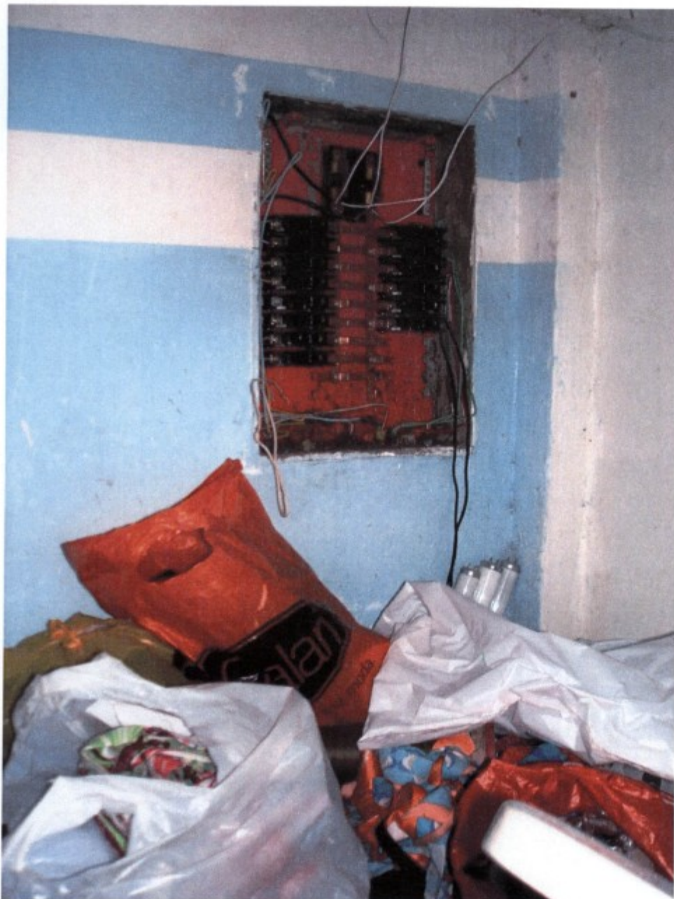
Complexo Oficinista da Casa Verde Alta – 11/08/2010 – quadro elétrico com partes vivas expostas, “gambiarras” e sem aterramento – próxima a material inflamável - risco de incêndio.
