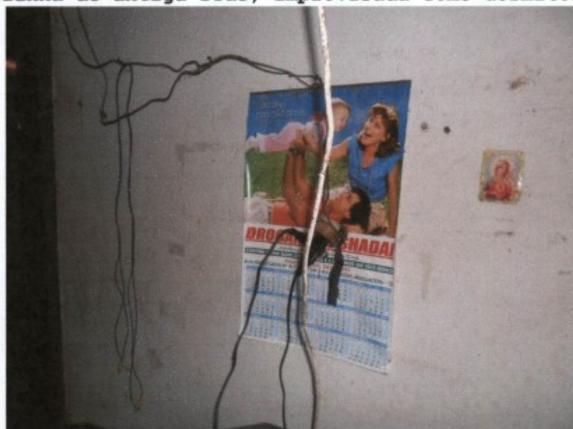
Gambiarras nas instalações - risco de incêndio e choque
