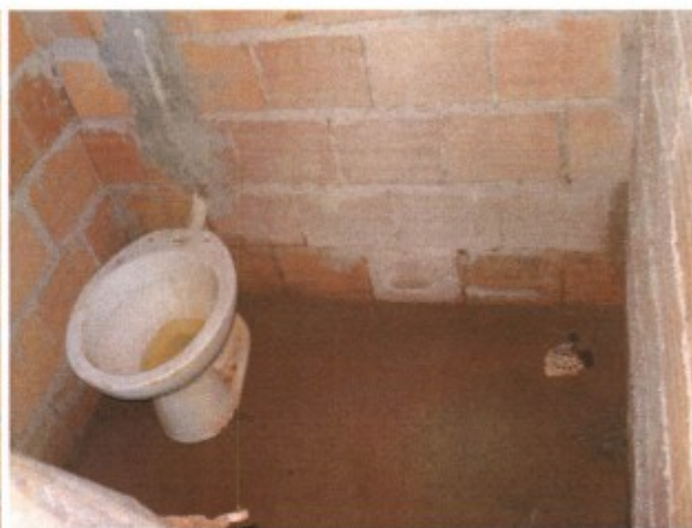
Fotos 29 e30 – Instalação sanitária sem porta e com paredes sem reboco.
