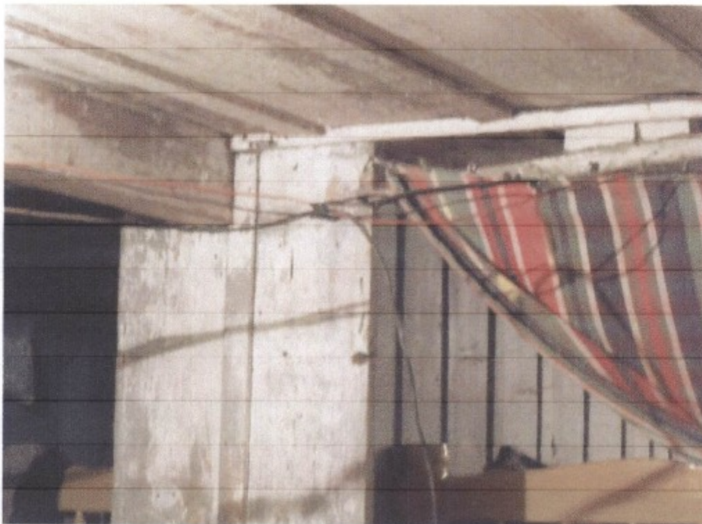
Fiação exposta e com emendas no alojamento: Risco de choque
