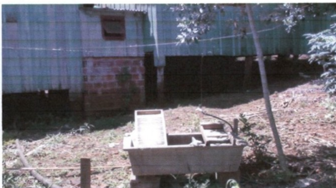
Tanque instalado a céu aberto, sem cobertura.
