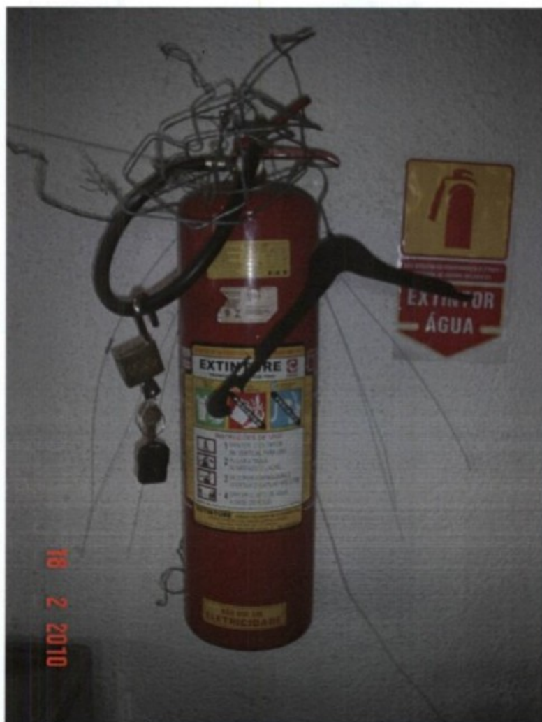
Imagem 58 - Oficina Sr. [REDACTED] 18/2/2010. Indústria e Com de Roupas GSV Ltda ME ("gato" Sr. [REDACTED]). Manter os extintores de incêndio encobertos por pilhas de materiais. Deixar de providenciar a pintura, em vermelho, de uma área de 1 m x 1 m no piso, embaixo do extintor de incêndio ou permitir que a área de 1 m x 1 m no piso, embaixo do extintor de incêndio, seja obstruída.
