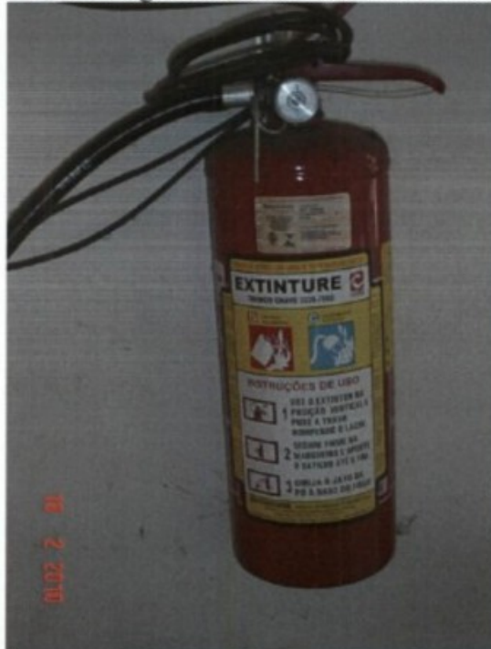
Imagem 60 - Oficina Sr. [REDACTED] - Indústria e Com de Roupas GSV Ltda ME ("gato" Sr. [REDACTED] - 18/2/2010 .Deixar de providenciar a pintura, em vermelho, de uma área de 1 m x 1 m no piso, embaixo do extintor de incêndio ou permitir que a área de 1 m x 1 m no piso, embaixo do extintor de incêndio, seja obstruída. Manter extintor de incêndio sem ficha de controle de inspeção.
