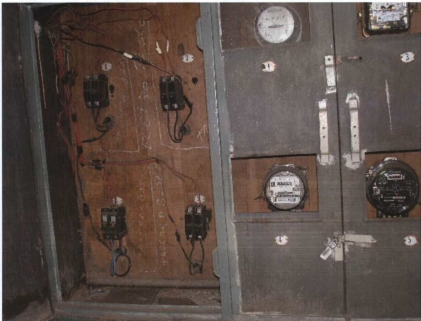
Imagem 74 - Oficina Sr. [REDACTED] - Indústria e Com de Roupas GSV Ltda ME ("gato" Sr. [REDACTED] 18/2/2010 – QUADRO DE ENTRADA - CONDIÇÕES DE RISCO DE CURTO CIRCUITO - Deixar de manter as instalações elétricas em condições seguras de funcionamento. Deixar de adotar, nas instalações e serviços em eletricidade, sinalização adequada de segurança, destinada à advertência e à identificação.
