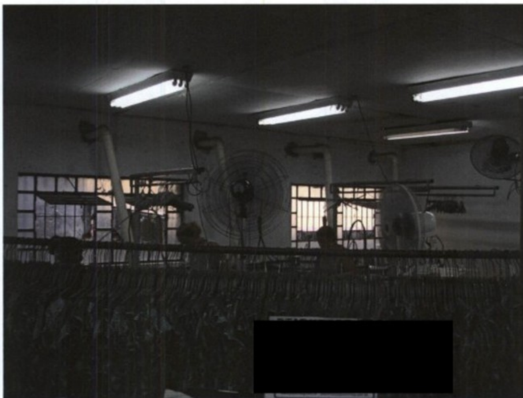
Imagem 40 - Bom Retiro- local de trabalho n. 4 – 22/02/2010 Deixar de manter as condições de iluminação de acordo com o previsto na NR-17 e outras normas regulamentadoras.
