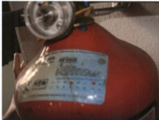
Imagem 59 - Oficina Sr. [REDACTED] Indústria e Com de Roupas GSV Ltda ME ("gato" Sr. [REDACTED] 8/2/2010 . Deixar de recarregar os extintores de incêndio do tipo espuma anualmente.
