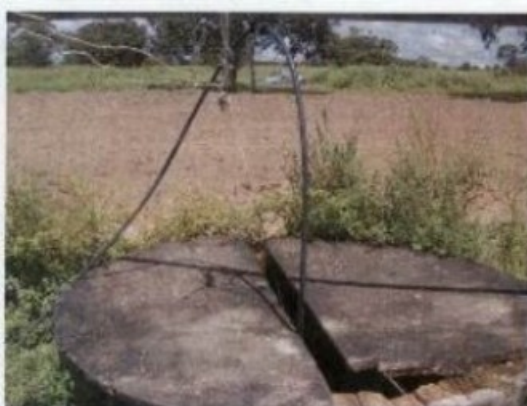
tampo da cisterna, quebrado
