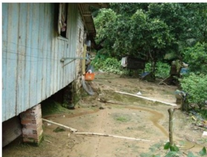
Esgoto da pia, escorre pela lateral da moradia.
