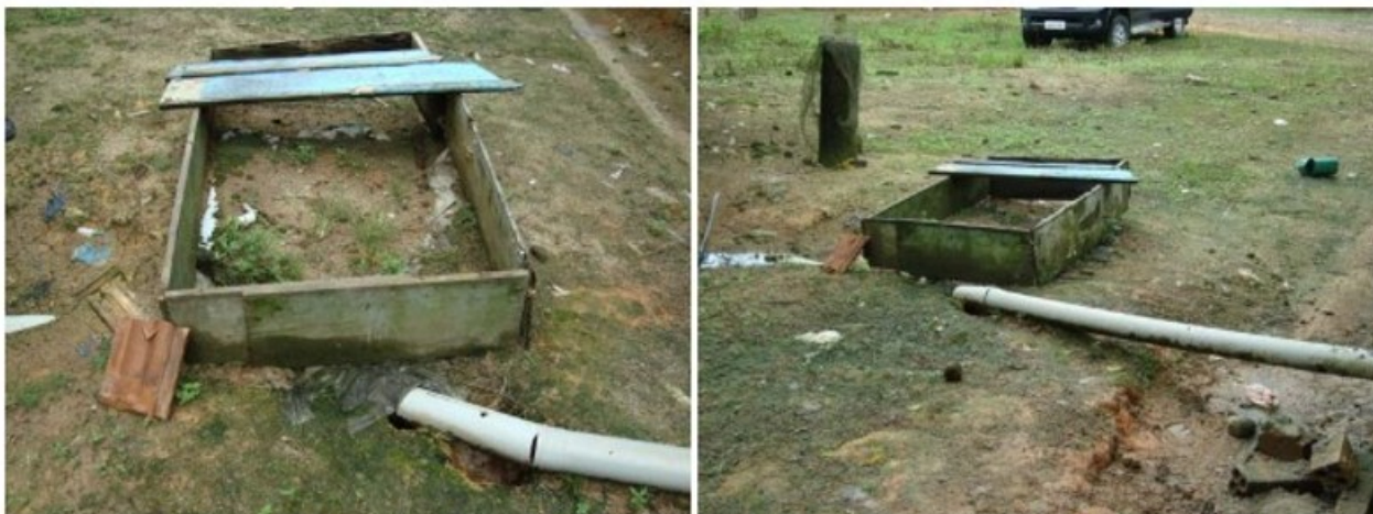
Vista de local onde localiza-se outra fossa séptica, com vazamento e exalando odor muito forte.
