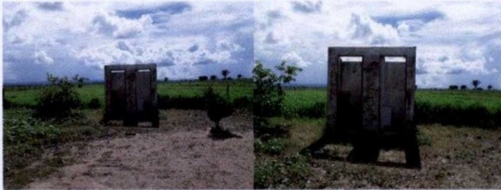
Foto: instalações sanitárias e chuveiro
