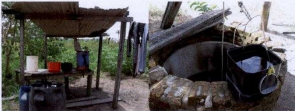
Foto: poços abertos e vasilhames inadequados Risco de contaminação da água
