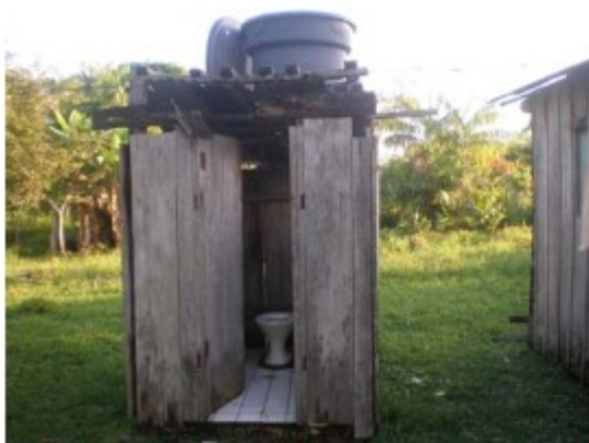
Cercado de madeira que fazia as vezes de banheiro. Observe-se que o vaso sanitário não tinha qualquer ligação com caixa d'água ou sistema de esgoto.
