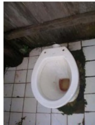
Cercado de madeira que fazia as vezes de banheiro. Observe-se que o vaso sanitário não tinha qualquer ligação com caixa d'água ou sistema de esgoto.
