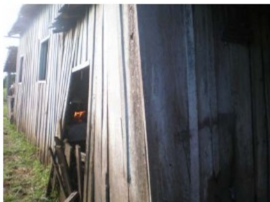
Fogão a lenha onde os trabalhadores cozinhavam as refeições. De se notar o risco oferecido pela precariedade da estrutura e pela proximidade do fogo das paredes de madeira.
