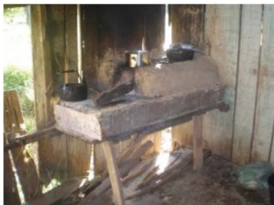
Fogão a lenha onde os trabalhadores cozinhavam as refeições. De se notar o risco oferecido pela precariedade da estrutura e pela proximidade do fogo das paredes de madeira.
