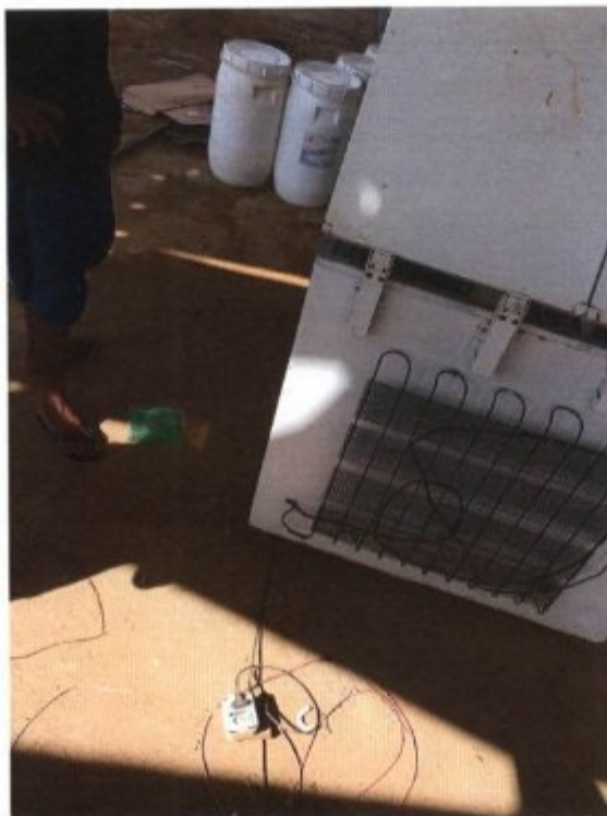
Figura 4 Instalação com risco de choque
