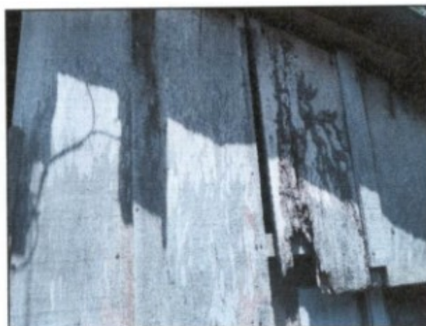
Fotos: Frestas existentes nas paredes do depósito de agrotóxicos, que eram de madeira.
