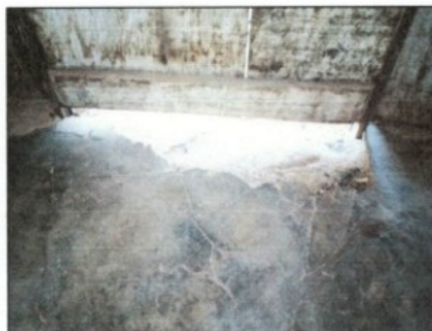
Fotos: Buraco no telhado e rachaduras no piso do alojamento.
