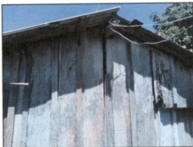
Fotos: Frestas existentes nas paredes do depósito de agrotóxicos, que eram de madeira.
