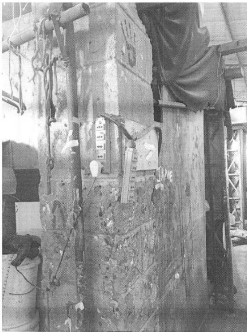
29/03/2017 - Prédio da sede da [REDACTED] Tomadas instaladas precariamente.
