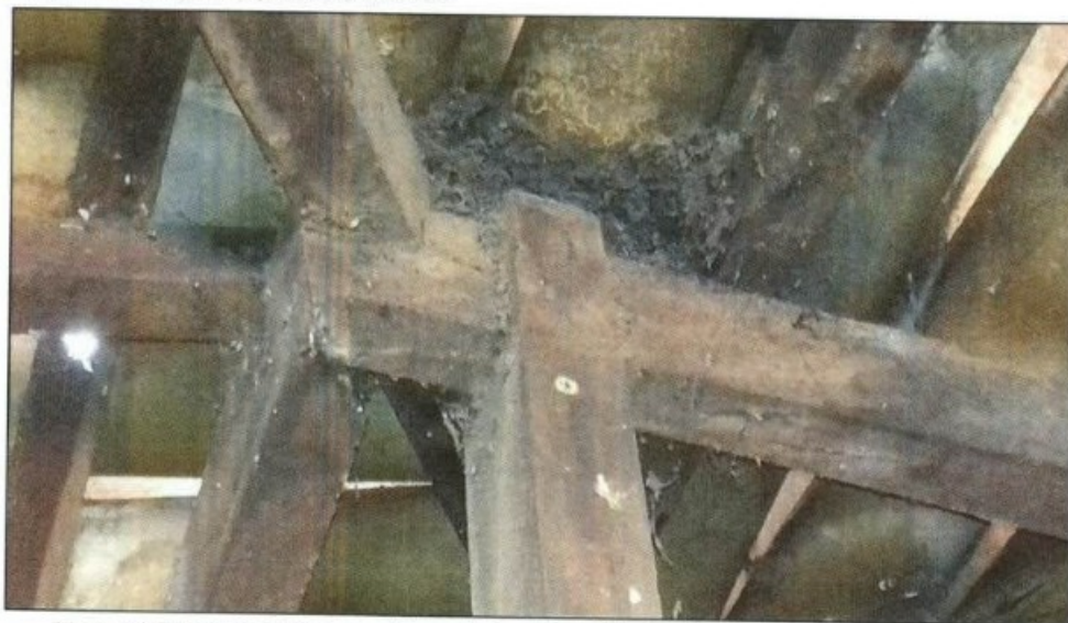
Foto: Cupins na estrutura de madeira do telhado da casa sede (alojamento).
