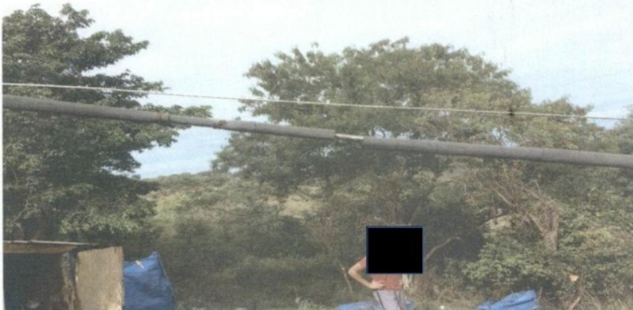
Foto 17: Rede elétrica improvisada, escorada em galhos de madeira, de baixa altura e desencapada.
