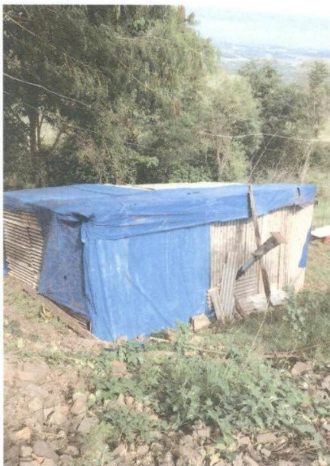
Foto 05 (à esquerda): Paredes do barraco construídas de forma improvisada com pedaços de telhas, madeiras e lonas. Foto 06 (à direita): Piso de terra batida sem nenhum revestimento.
