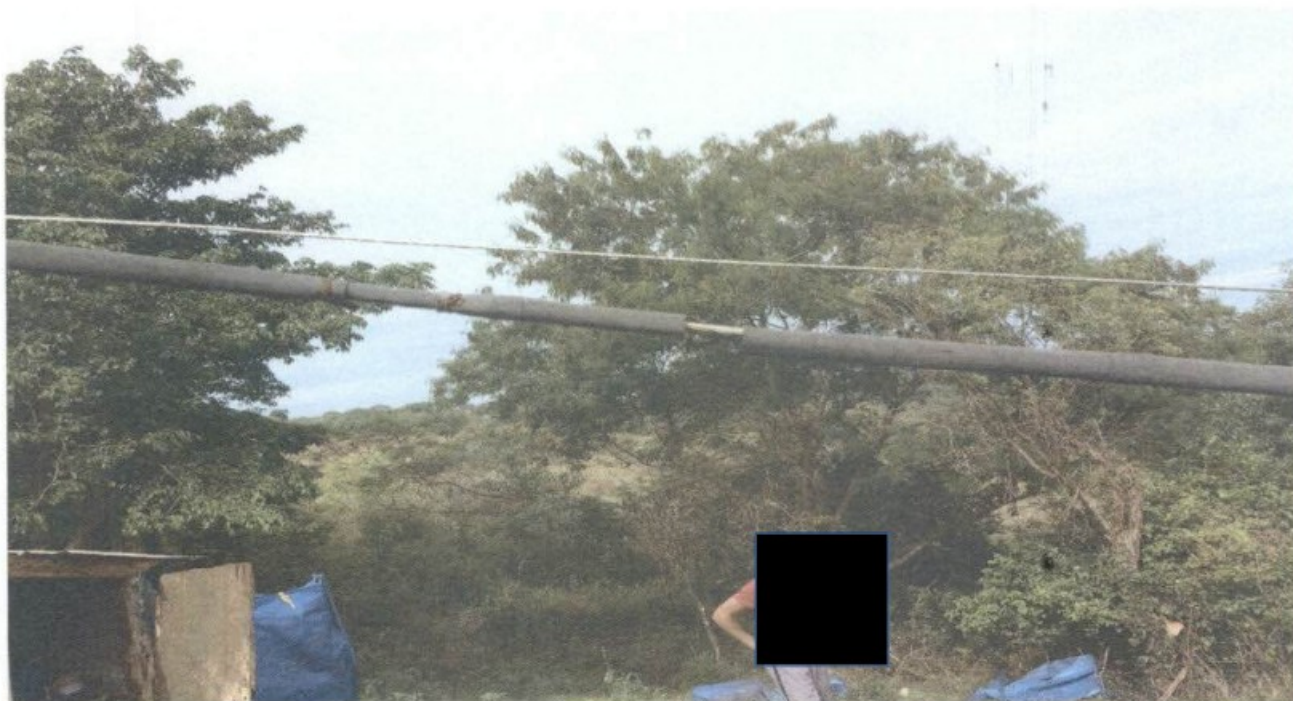
Foto 15: Rede elétrica improvisada, encostada em galhos de madeira, de baixa altura e desencapada.
