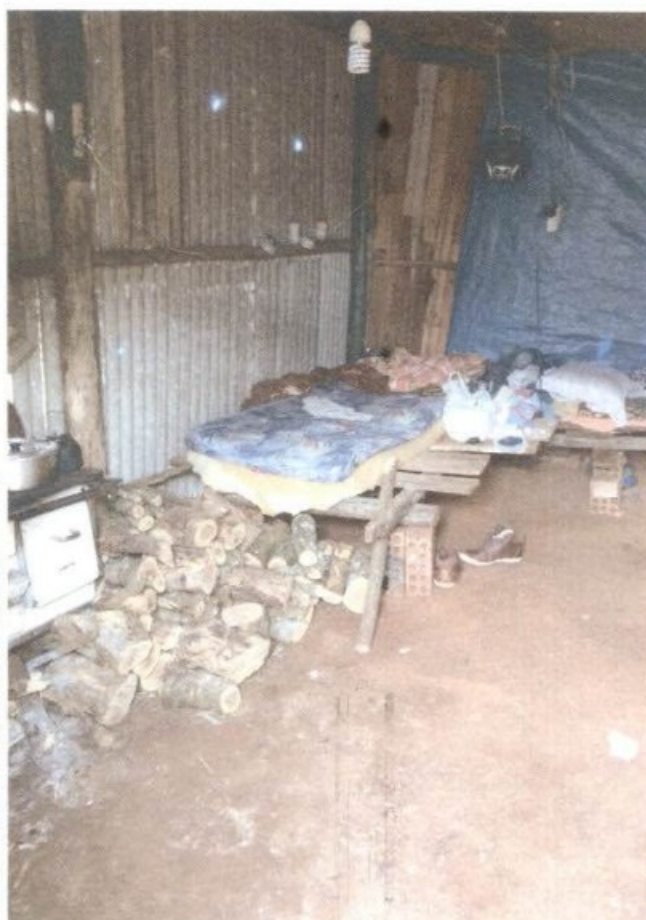
Foto 05 (à esquerda): Paredes do barraco construídas de forma improvisada com pedaços de telhas, madeiras e lonas. Foto 06 (à direita): Piso de terra batida sem nenhum revestimento.
