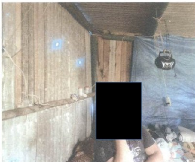
Foto 15: Rede elétrica improvisada, encostada em galhos de madeira, de baixa altura e desencapada.
